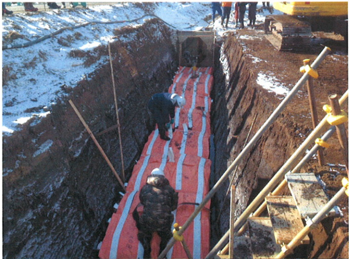
左下の写真：事務所棟の地盤補強と振動低減対策（埼玉県）
